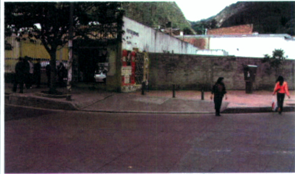
Fotografía 6. Se observan las buenas condiciones de las vías con adecuadas obras de drenaje.
