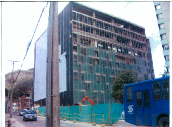
Fotografía 8. Edificación de más de 10 niveles que se construye actualmente.
